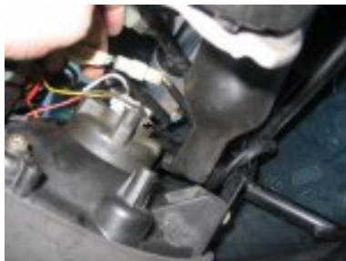
brancher les connecteurs électriques lié à l'éclairage
