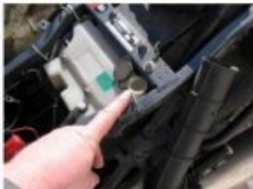
Rempl. circuit refroidissement
