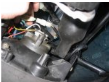
brancher les connecteurs électriques lié à l'éclairage
